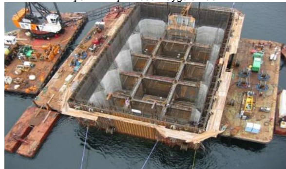
Şekil 1. Açık Keson Uygulaması
