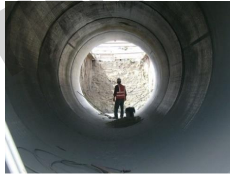
Resim 1. Çelik Palplanş Uygulaması (Küçükçekmece Eşkinöz Deresi/ASM İnşaat)
