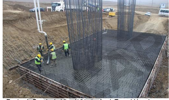
Resim 1. Derekişla Viyadüğünün Ayak Temel Uygulaması
